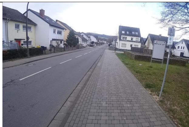
Foto 4: Bestandssituation; Gehweg mit HBR-Wegweisung zwischen den Einmündungen der Mühlenstraße
