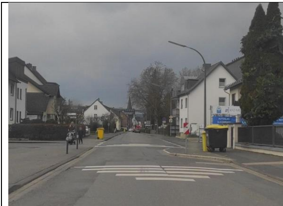
Foto 1: Bestandssituation; Ehlinger Straße / Im Bülland, Engstelle
