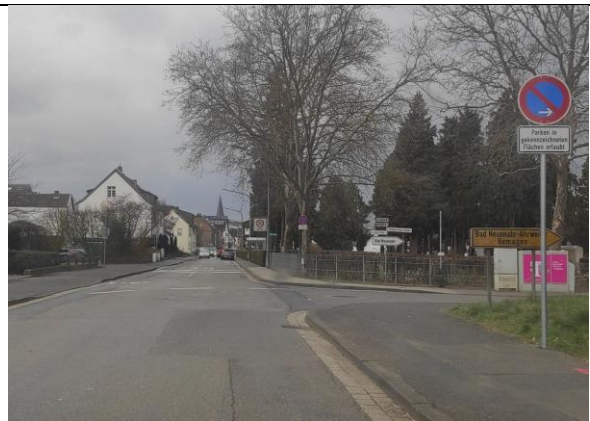
Foto 2: Bestandssituation; Abknickende Vorfahrt Ehlinger Straße / Kloster-Prüm-Straße
