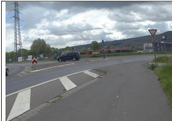
Foto 3: Bestandssituation; Zufahrt L 83 Ringener Straße
