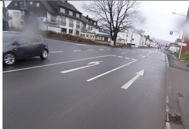
Foto 2: Bestandsituation; Kreuzung Schützenstraße / St.-Pius-Brücke
