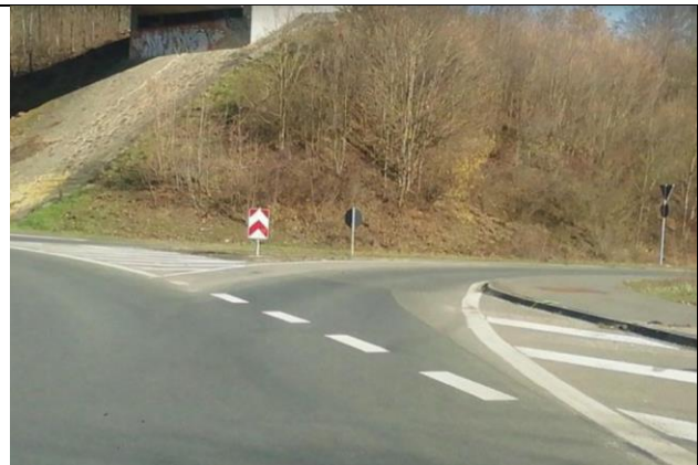
Foto 2: Bestandssituation; Ende des umlaufenden Wegs an der Zufahrt Heerstraße
