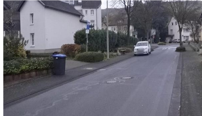
Abbildung 12: problematische HBR-Beschilderung zwischen Heppingen und Bad Neuenahr
