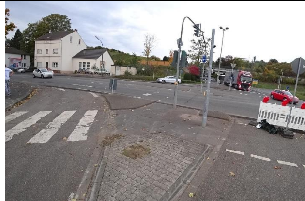
Foto 6: Bestandssituation; Kreuzung Landskroner Straße / Im Schwertstal, Fahrtrichtung Süd zurückgebaut
