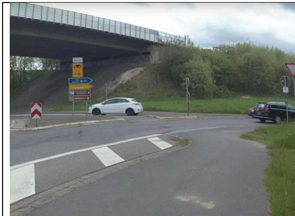
Foto 1: Bestandssituation; die als Gefahrenstelle meistgenannte Zufahrt der L 84
