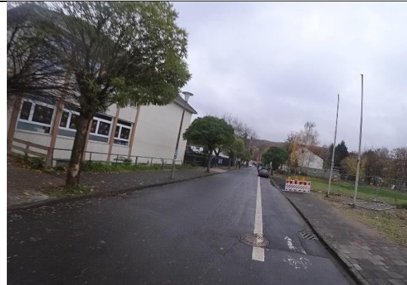
Foto 2: Bestandssituation; Hemmesser Straße mit Radfahr- / Parkstreifen
