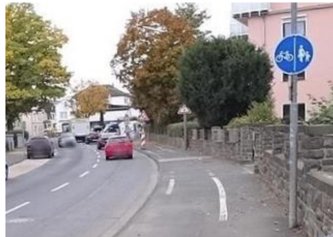
Abbildung 13: problematische Benutzungspflicht des Radwegs an der Hauptstraße
