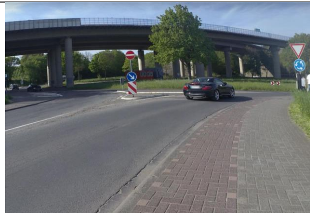
Foto 4: Bestandssituation; Getrennter Rad- und Gehweg auf der L 83 Ringener Straße
